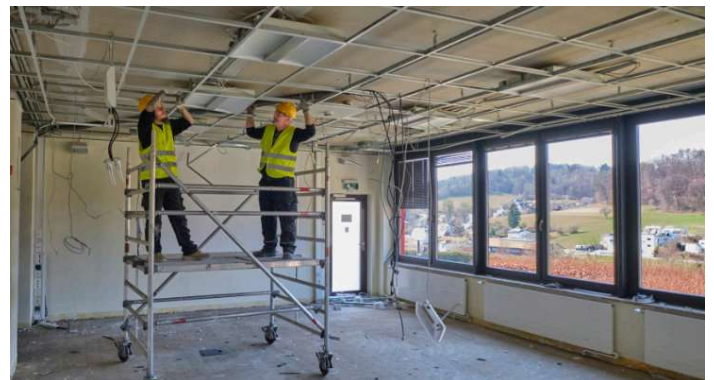
Demontage von Gipskartondecken und Leuchtmitteln in den Vortragssälen.
