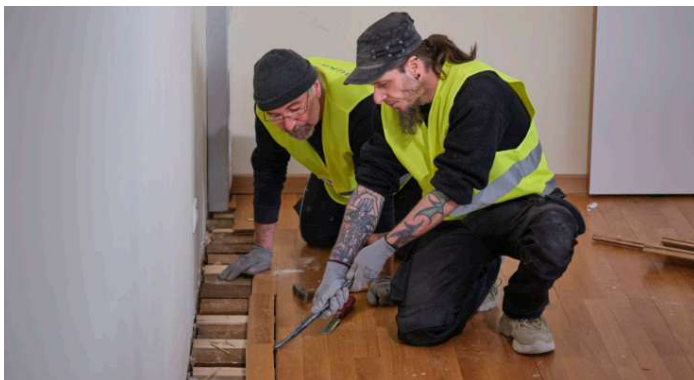
Zerstörungsfreier Ausbau des Eichen-Massivparketts aus dem Speisesaal.
